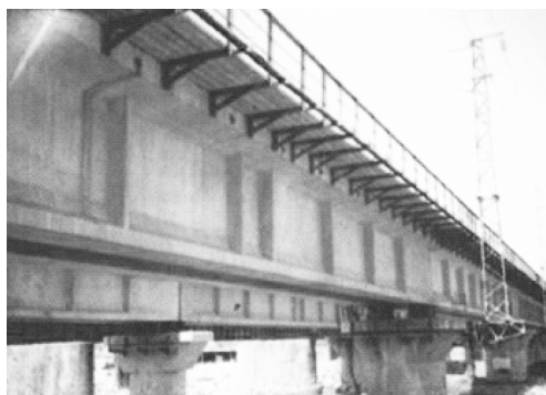
图 1-3 抗冻混凝土桥梁
