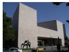
美国国家艺廊东楼(1978)
