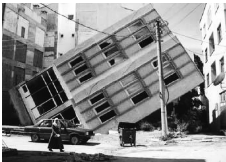
图 1-12 我国台湾南投县集集镇地震时地基失效造成房屋倾倒
