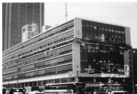
图 1-11 日本阪神地震时某公共建筑整层破坏
