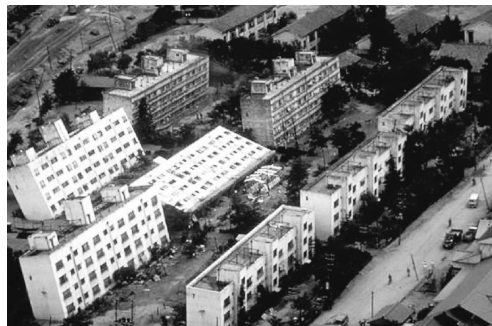
图 1-13 日本新潟地震时砂土地基液化导致房屋倾斜
