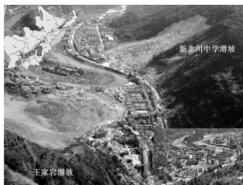
图 1-9 汶川地震时北川县城发生的两处滑坡
