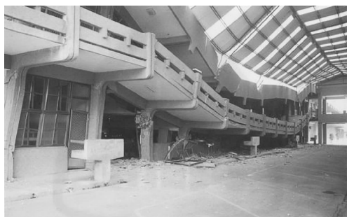
图 1-10 我国台湾南投县集集镇地震时某学校教学楼的主体结构破坏
