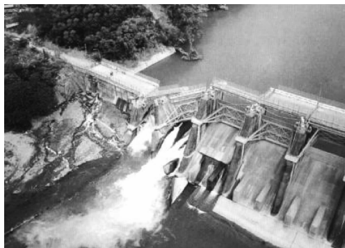
图 1-15 我国台湾南投县集集镇地震时水坝结构被震坏
