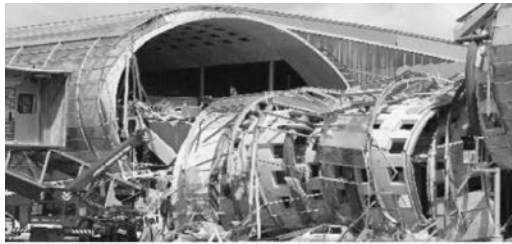
(a) 坍塌的机场候机厅
