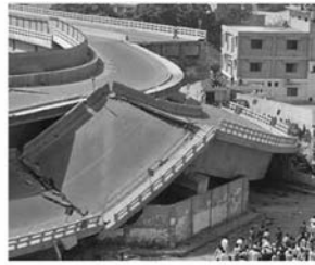
(b) 坍塌的公路大桥
